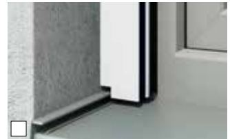
Je nach Art der Fensterbank, kann die rollSCREEN.2 Führungsschiene für eine perfekte Montage ausgeklinkt werden.
